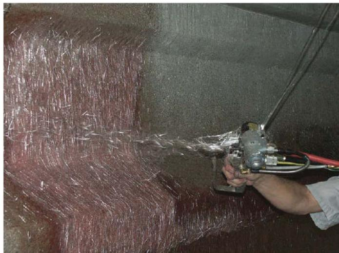
شکل ۵- نمایی از تعمیر تیر بتنی پیش تنیده با اسپری GFRP
