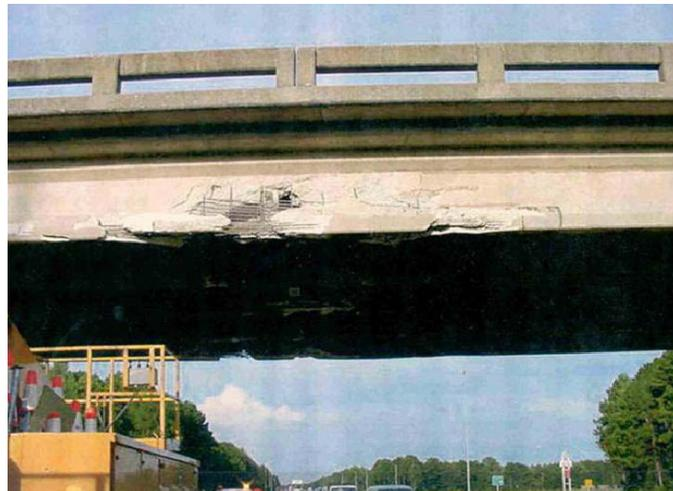
شکل ۱- خسارت ناشی از برخورد وسایل نقلیه به تیر بتنی پیش تنیده پل
